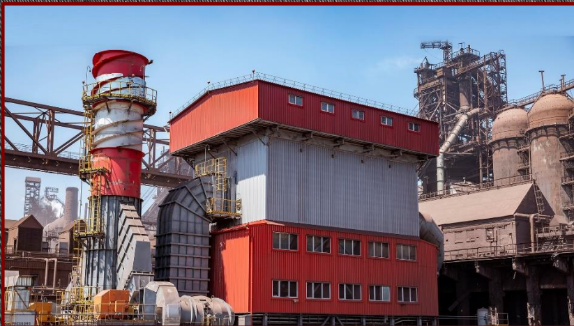
Газоочистка доменной печи №3 ЧАО “ММКИ”
