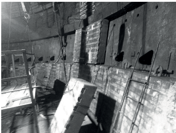
Рис. 1. Замена холодильников на доменной печи объемом 5000 м 3
