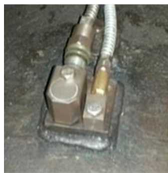
Рисунок 5.3 – Монтаж датчика темпе- ратури ТП02 (праворуч)
