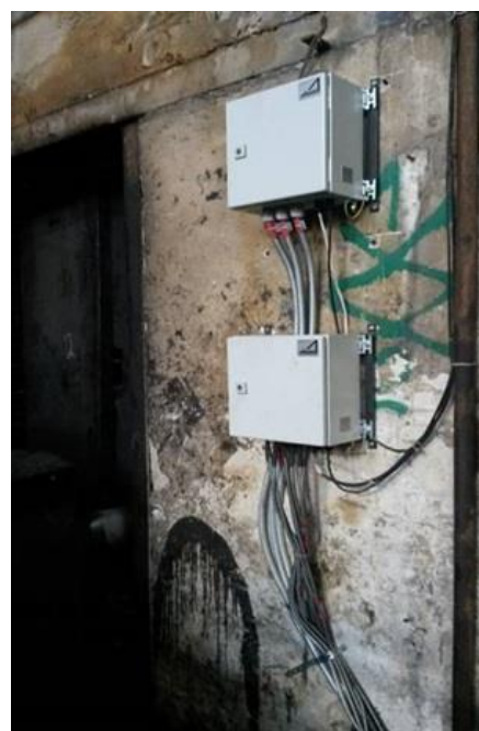
Рисунок 5.6 – Змонтований блок вимірювальний «Корунд»
