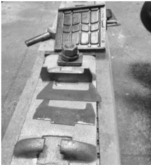
Рисунок 5.4 – Скріплення типу СКД65-Бп
