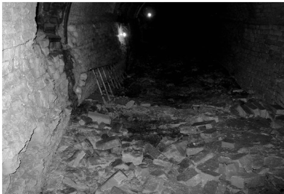
Фото 2. Засоренность дымового борова фрагментами огнеупоров
