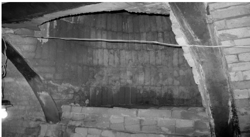
Фото 3. Дымовой патрубок воздухонагревателя, входящий в общий боров
