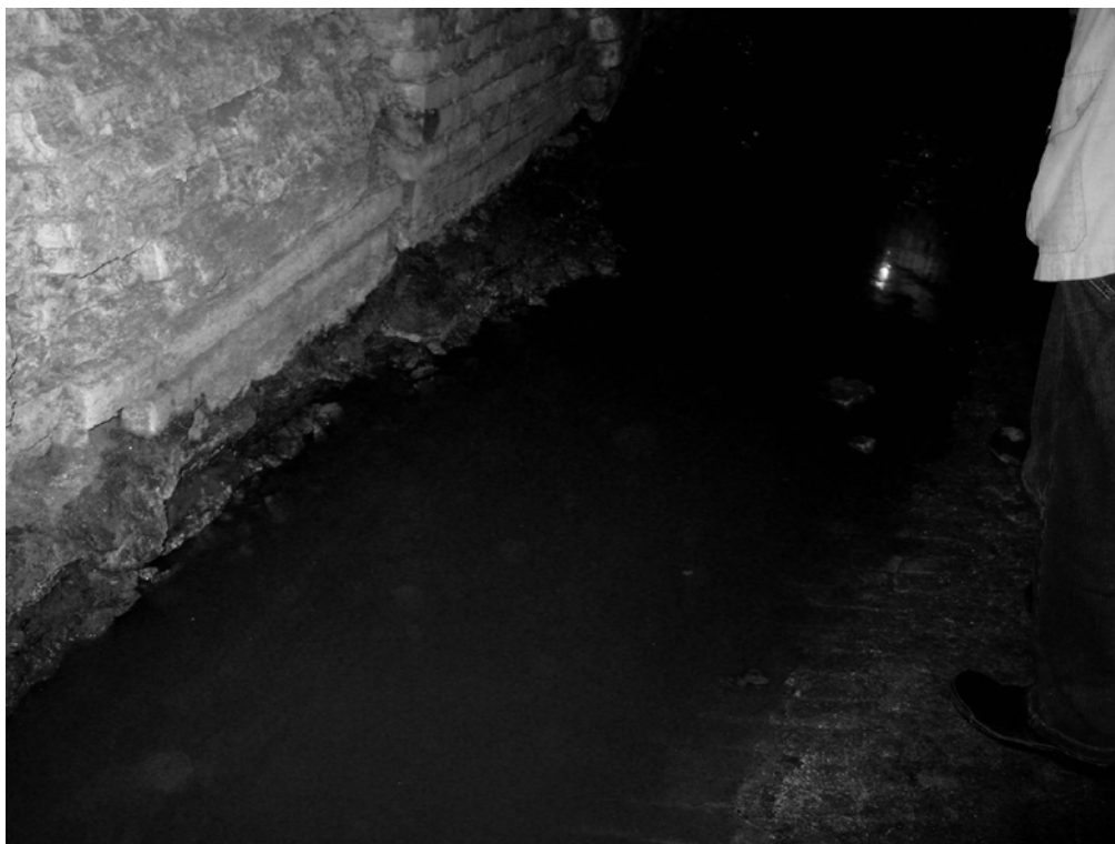
Фото 1. Уровень грунтовых вод внутри дымового бора
