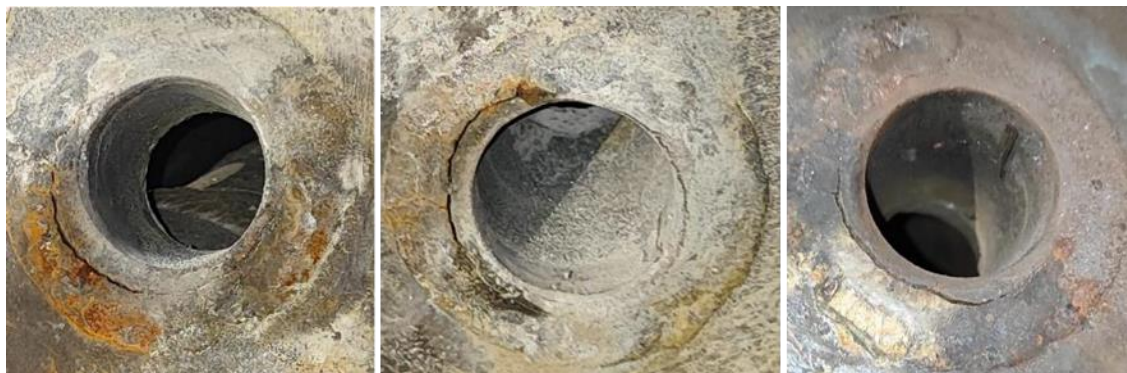
Рисунок 1 – Тріщини зварного шва між соплом і зовнішньою обоймою наконечника фурми
