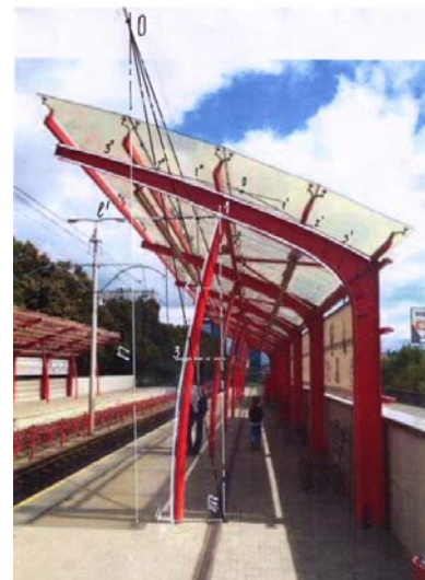
Рис. 7. Використання гіперболи і параболі в обрисах конструкцій трамвайної зупинки
